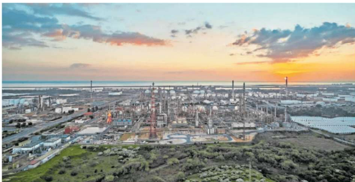
Vista aérea del parque energético de La Rábida, Huelva, propiedad de Moeve. GONZALO PUERTO
